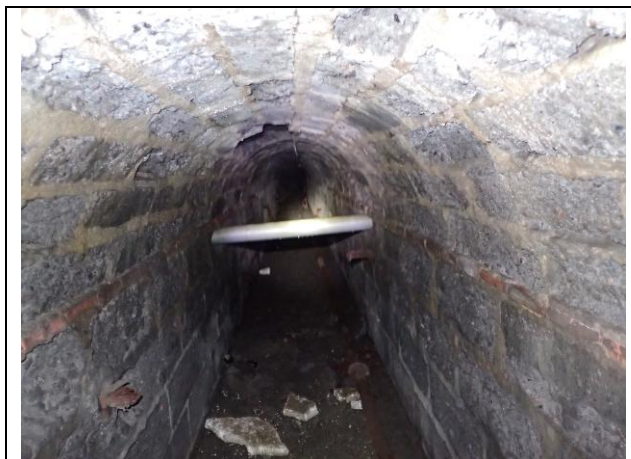
Photo de la galerie à combler
